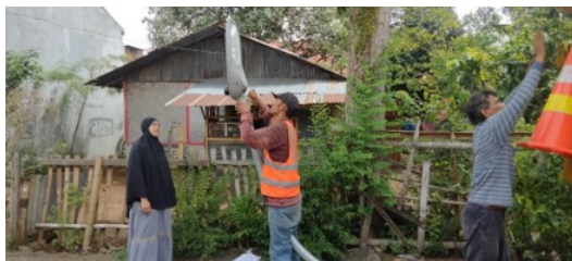
Gambar 3. Kegiatan pemasangan lampu photocell pada titik 1
