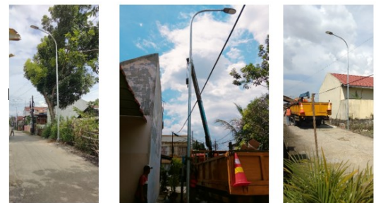
Gambar 6. Hasil pemasangan photocell yang selesai dikerjakan pada 3 titik lokasi
