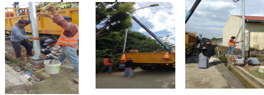
Gambar 5. Proses pemasangan tiang lampu
