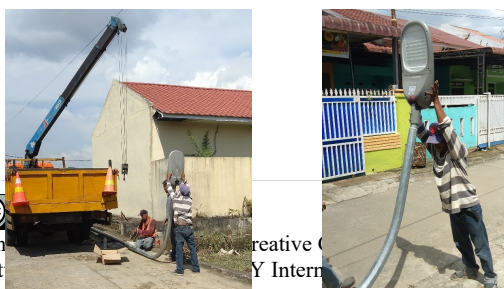
Gambar 3. Kegiatan pemasangan lampu photocell pada titik 1
