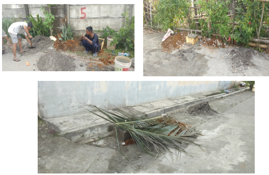
Gambar 2. Lokasi Pengecoran pondasi tiang lampu jalan umum
