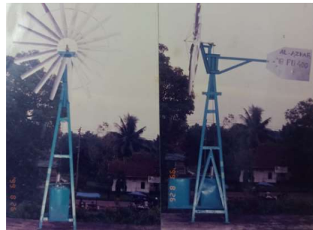
Gambar 6. Photo Konstruksi Menara
